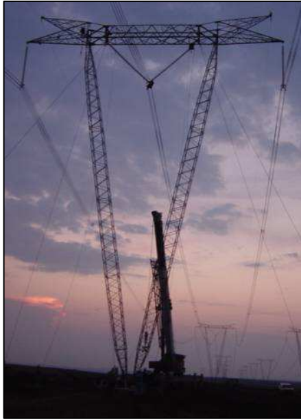
Figura 3 – Torre estaiada 750kV CA
