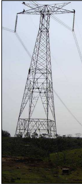
Figura 6 – Torre autoportante 750kV CC
