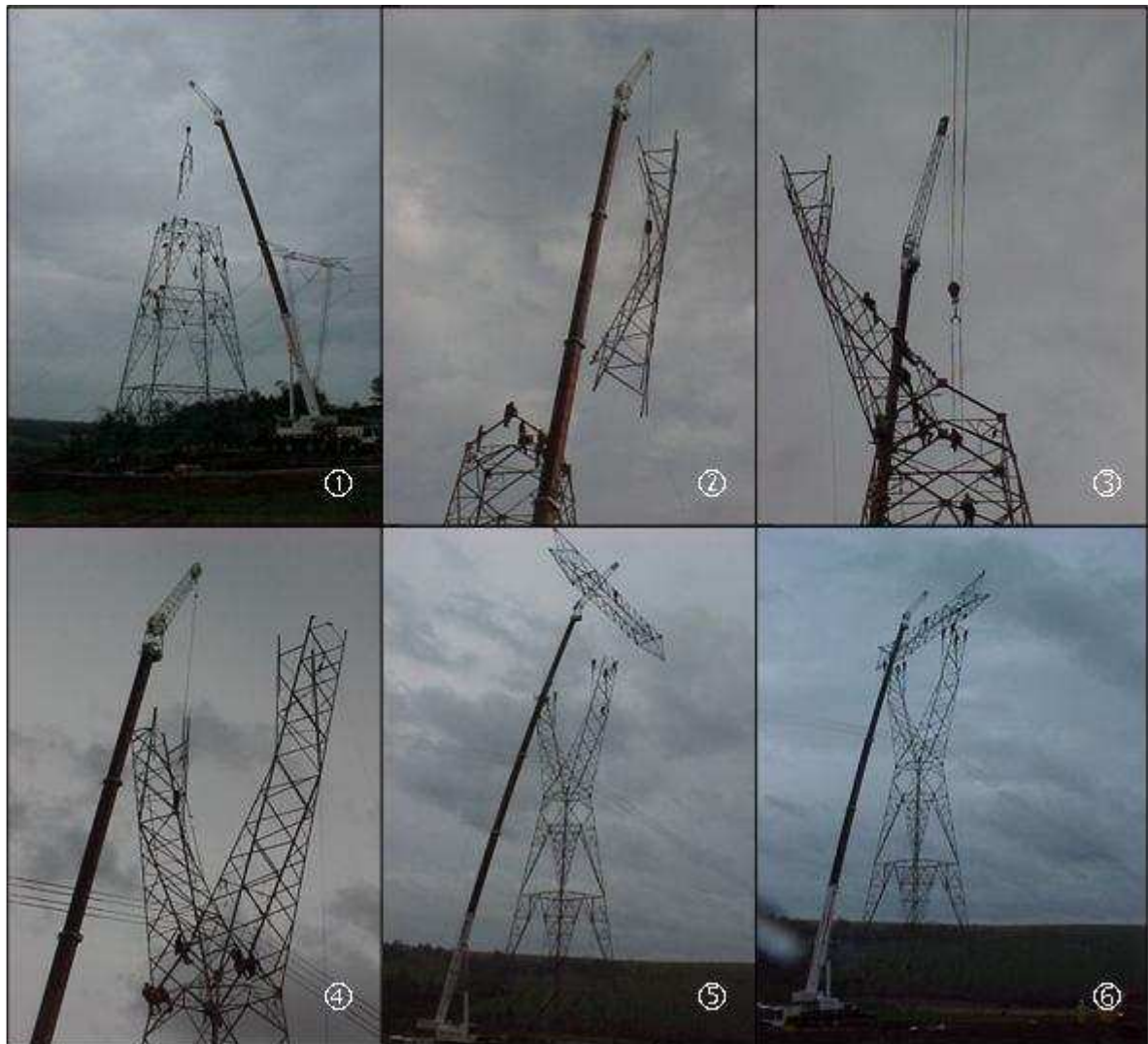
Figura 8 – Seqüência de montagem de estrutura de linhas de transmissão por guindaste. Fonte: Arquivo Furnas.
