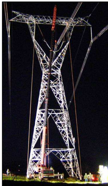
Figura 4 – Torre autoportante 750kV CA
