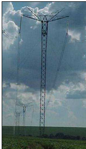
Figura 5 – Torre estaiada 600kV CC
