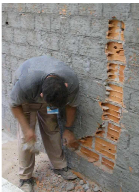
Figura 11: Rasgo em alvenaria executado manualmente.
