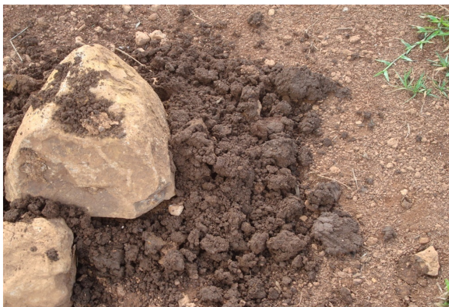
Figura 2: Construção do poço de determinação da profundidade do lençol freático.
